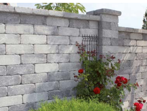
Zidovi i ograde
